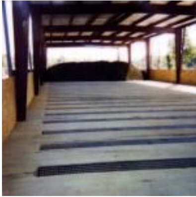
Слика 5-8: Бетонски канал на подот од перфорираната подлога со цевковод што доставува кислород до масата што се компостира
