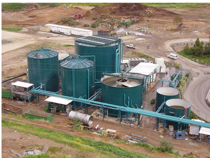
Слика: Типична постројка за анаеробна дигестија што е дел од постројката за МБТ
