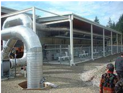
Слика 5-9: Систем за аерација на постројка со затворена комора за компостирање
